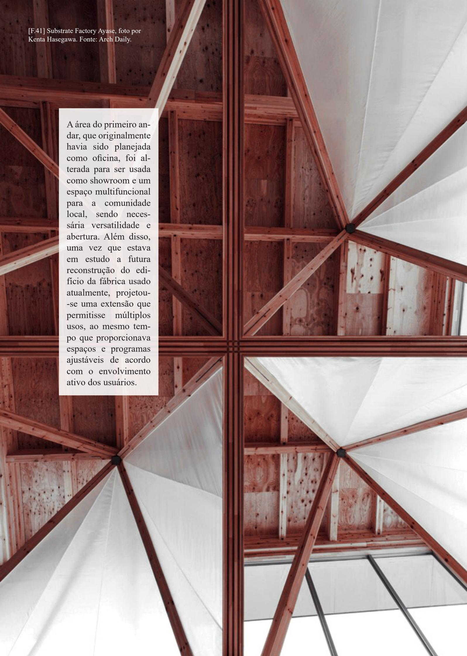
Este edifício é construído com um modelo de estrutura de quadro projetado para acomodar várias condições e requisitos, bem como elementos de encaixe e hardware que permitem um ajuste fino, melhorando sua capacidade de ajuste e renovabilidade. Esses espaços do edifício caracterizam-se pela composição que justapõe esses elementos sem perder as suas características originais. O local é categorizado pela zona urbana semi-industrial, onde coexistem fábricas e residências
