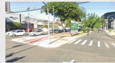
▲ Ciclovia - Vista da Rua Dona Gercina Borges Teixeira Fonte: Google Maps, 2021
