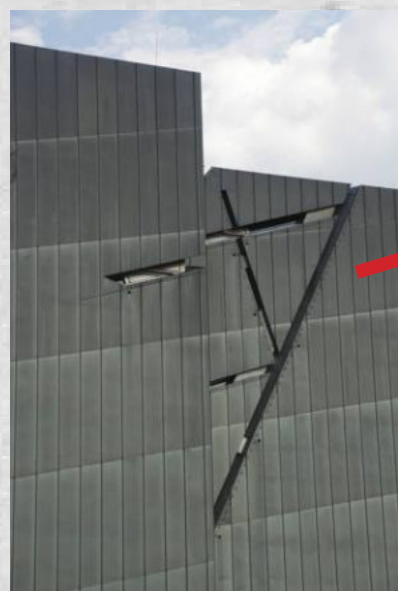
Fachada de Zinco Fonte: ArchDaily
