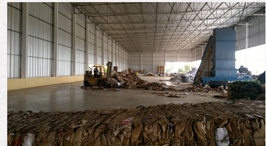
Figura 14: Interior de galpão de processamento da Copel, Aparecida de Goiânia, Goiás. Fonte: Site oficial da Copel Reciclagens, s/d.
