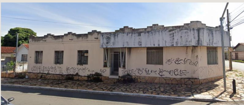
[19] Edifício com traços Art Déco, passando por um processo de abandono, mas mantendo suas características. Fonte: Google Maps, 2022.
