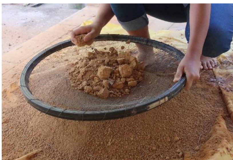
Figura 3.6: Preparação da terra Fonte: do autor (2019)
