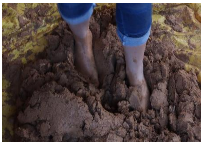
Figura 3.8: Processo de amassar o barro Fonte: do autor (2019)
