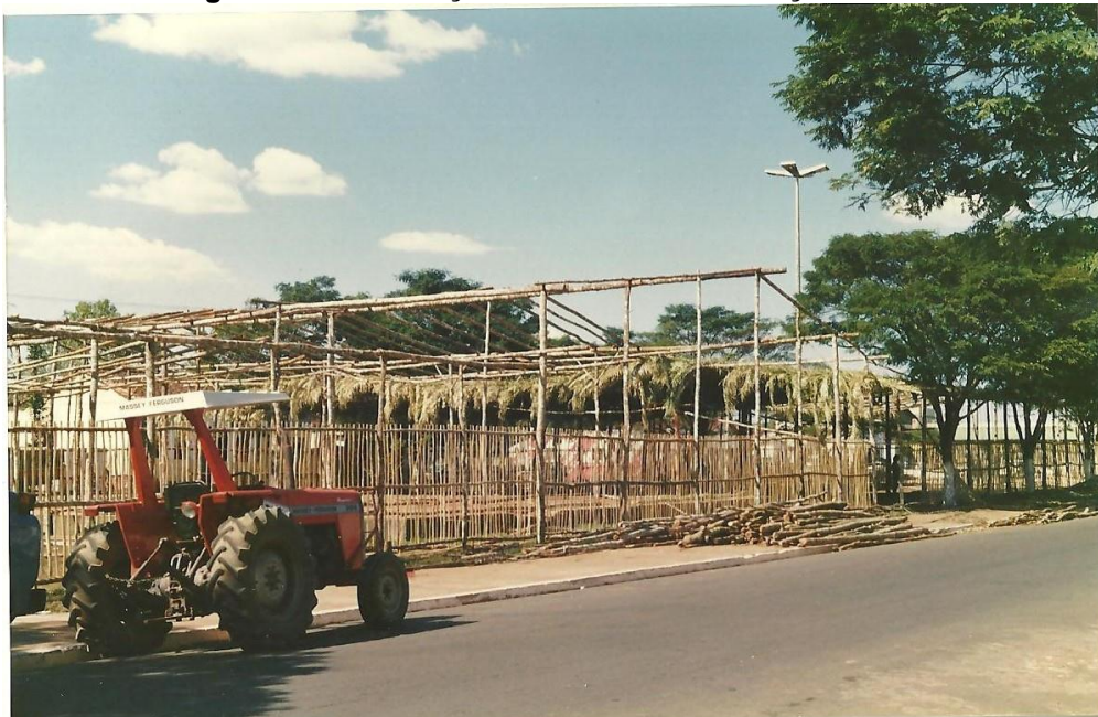
Fotografia 6 - Construção do “Ranchão da Praça” em 1990.
