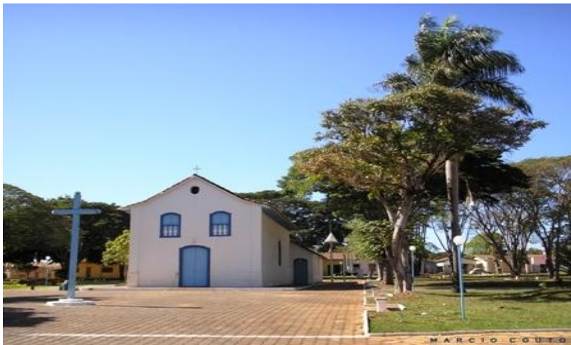
Imagem 2: Capela de Nossa Senhora da Abadia após a restauração.
