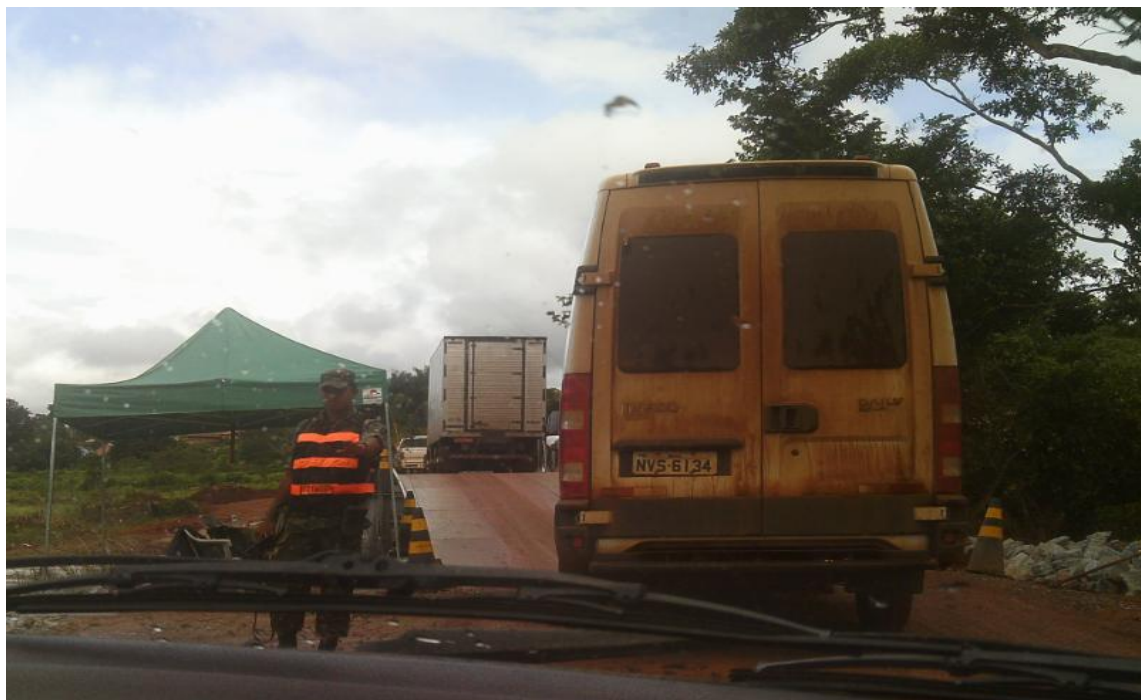
Imagem 20: Foto da Ponte Provisória sobre o Rio das Pedras – Itaberaí - GO
