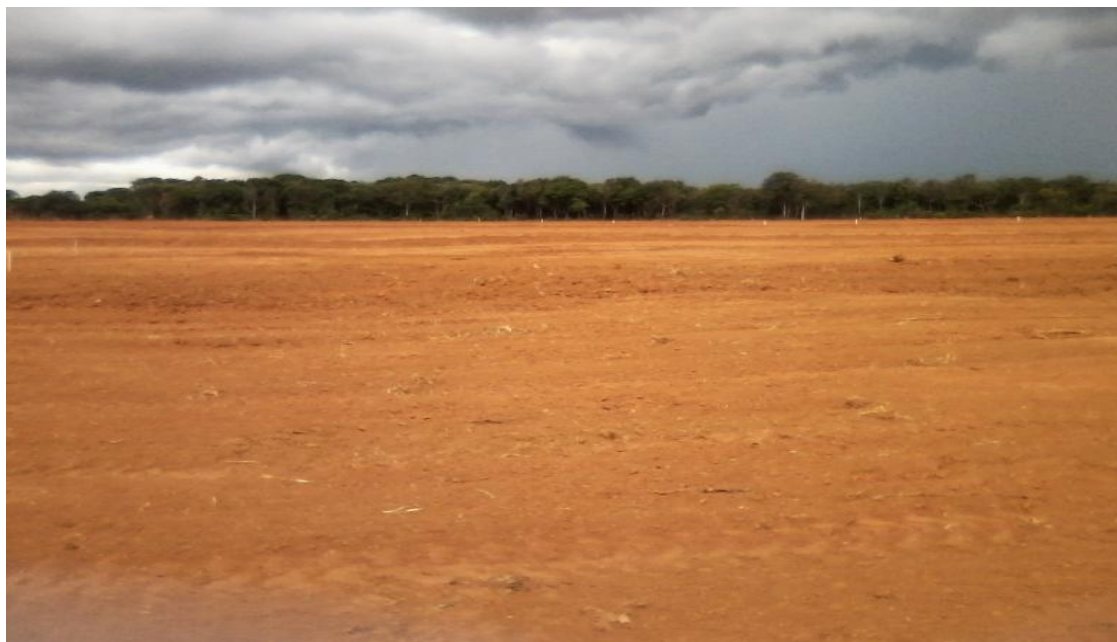
Imagem 9: Área desmatada para implantação de conjunto Habitacional em Itaberaí – GO.
