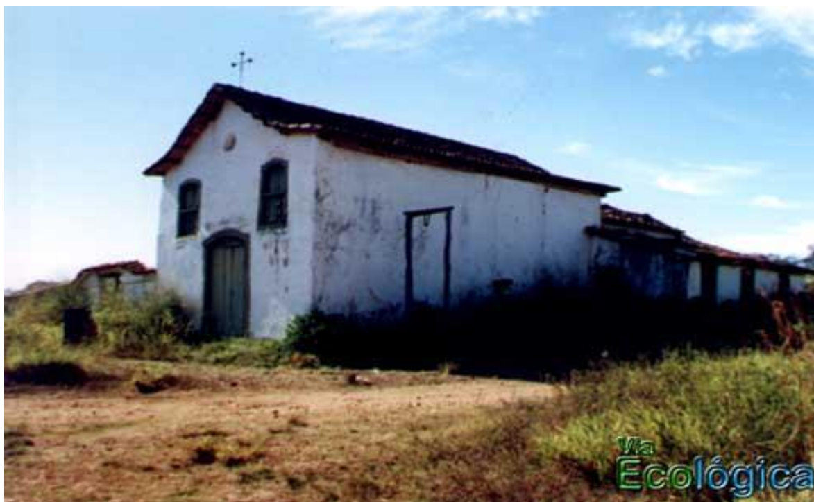
Imagem 1: Capela de Nossa Senhora da Abadia.
