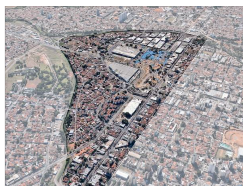
FIGURA 46: Área de intervenção. Fonte: GOOGLE EARTH, 2016. Org. pelo Autor, 2016.
