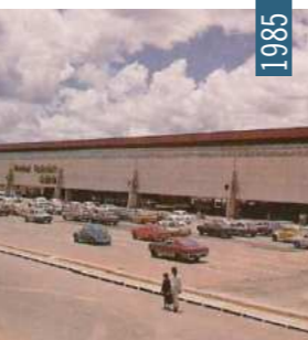
FIGURA 39: Terminal Rodoviário de Goiânia, 1985. Fonte: LEMOS, 2007.
