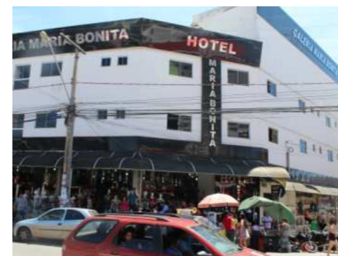
Figura 182: Edificação de uso misto, com comércio popular no térreo e Hotel nos pavimentos superiores, na Av. Contorno. Fonte: Acervo pessoal, 2016
