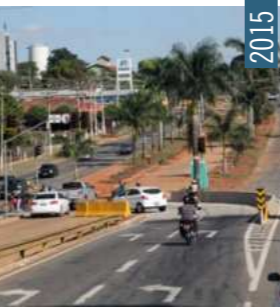
FIGURA 45: Avenida Goiás Norte, com intervenções para construção do BRT Norte-Sul. Fonte: Jornal O POPULAR, 2016.
