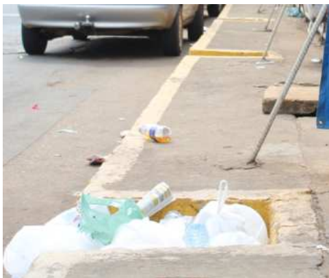
Figura 122: . Problemas de drenagem - Local para escoamento de água pluvial coberto por lixo. Fonte: Acervo pessoal, 2016.
