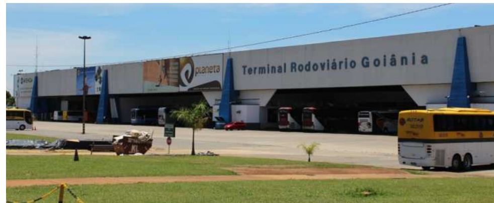
Figura 135: Fachada lateral do Terminal Rodoviário de Goiânia com ônibus em plataformas de embarque e desembarque de passageiros. Fonte: Acervo pessoal, 2016
