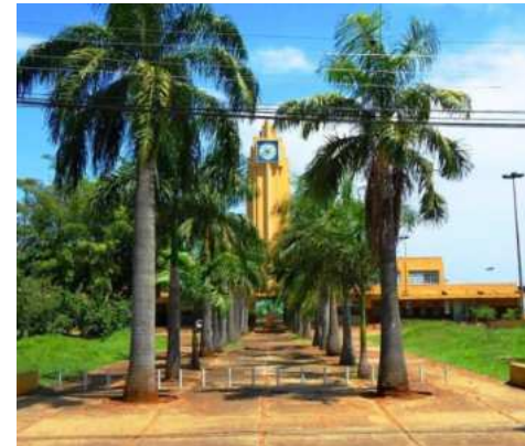
Figura 158: Estação Ferroviária na Praça do trabalhador, um marco de referência devido seu estilo e monumentalidade. Fonte: http://www.skyscrapercity.com/showthread.php?t=1632758
