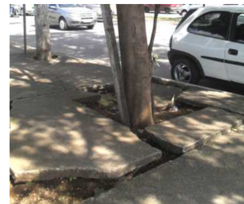
Figura 87: Av. Independência com a presença de espécies de árvores impróprias devido a proporção de suas raízes que danificaram as calçadas, reduzindo o espaço de circulação do pedestre. Fonte: Acervo pessoal, 2016
