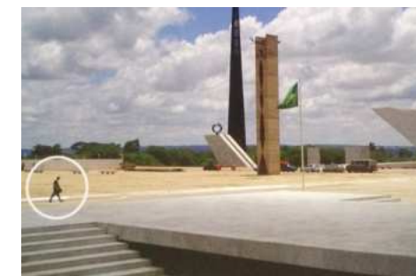
Figura 03: Praça dos três poderes de Brasília, um espaço urbano não convidativo. As pessoas se tornam pequenas nesta escala monumental dos edifícios e praças. Fonte: Gehl, 2015
