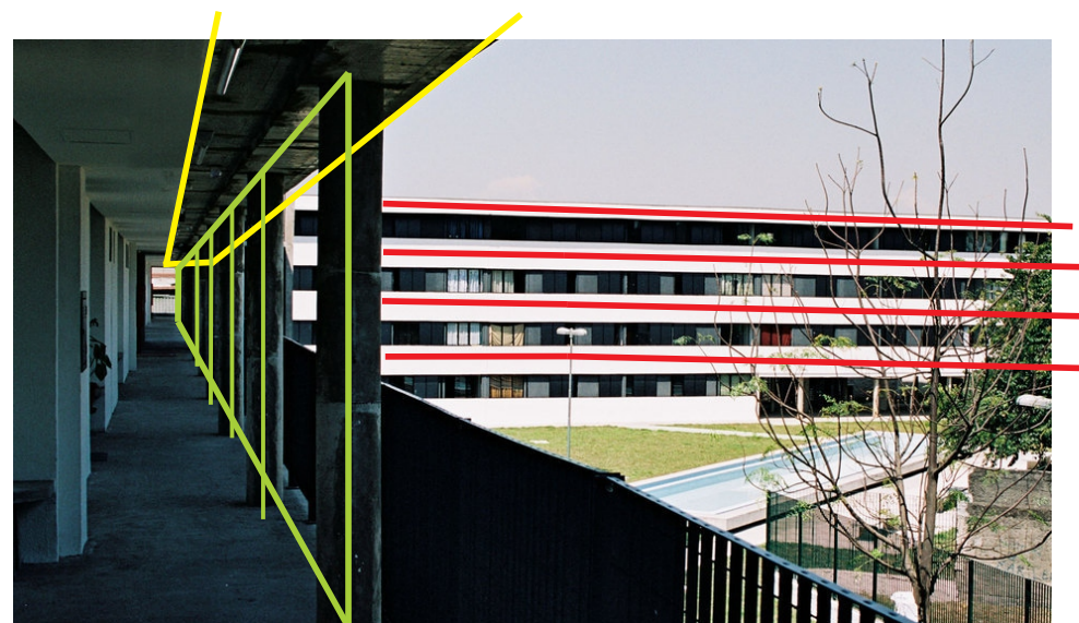
Figura 25: Acabamento, modulação dos pilares e lajes Fonte: VIGLIECCA&ASSOCIADOS e autora,2016
