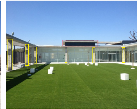
Figura 35: Modulação dos pilares em amarelo. Fonte: Archdaily, 2016
