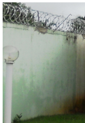
Figura 10: Muro com concertina Fonte: Autora, 2014.
