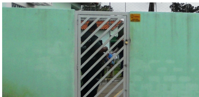
Figura 16: Muro com guarda. Fonte: Autora, 2013
