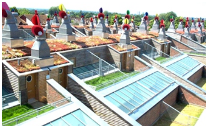
Figura 61: BedZED - teto verde e placas fotovoltaicas. Fonte: Wikimédia.org
