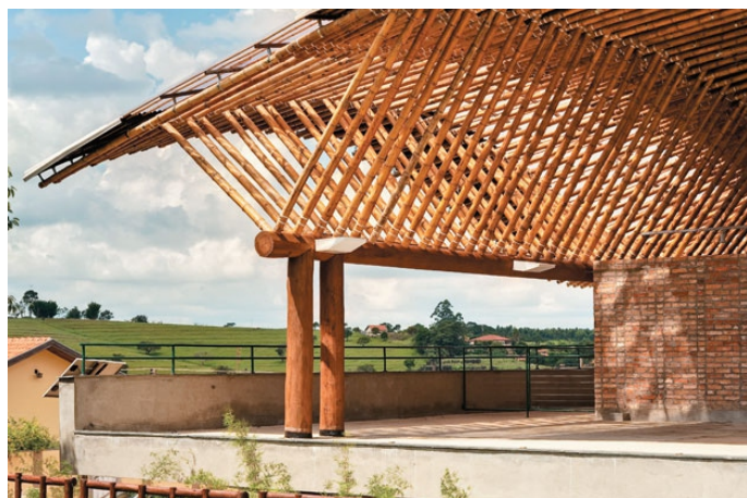
Figura 87: Estrutura em bambu com coluna de madeira de lei
