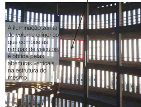
A iluminação zenital do volume cilíndrico que compõe as rampas de veículos, é obtida pelas aberturas verticais na estrutura do mesmo
