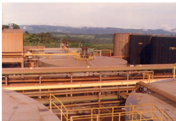
Fotos 1 e 2 dos decantadores da seção 700 - Votorantim Metais. (Fotos: Dimas Antônio da Silva, 1982).
