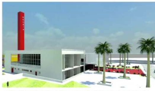
FIG.21- VISTA DA BIBLIOTECA: MARQUISE E BRISE VERTICAL PARA PROTEÇÃO SOLAR
