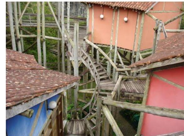
Figura 13: detalhe da estrutura em eucalipto e vista da escada interna.
