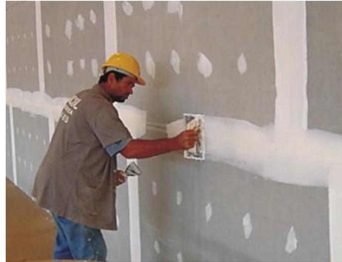
Figura 53: depois de parafusadas, são rejuntadas e Estão prontas para receber o revestimento ou pintura
