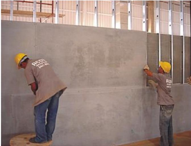
Figura 52: as placas são parafusadas na estrutura
