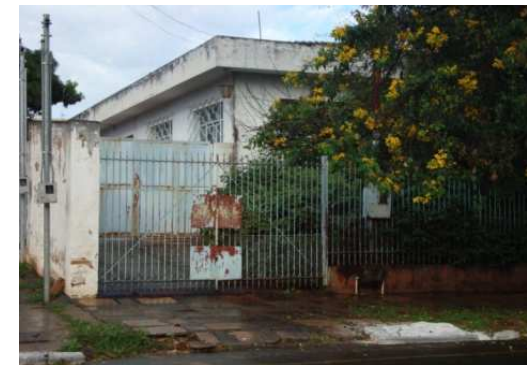
Figura 2.12 – Casa em mau estado de conservação (Arquivos pessoais, 2011)
