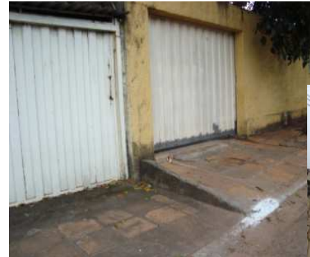
Figura 2.10 – Desnível impróprio (Arquivos pessoais, 2011)
