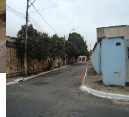
Figura 2.9 - Calçadas estreitas (Arquivos pessoais, 2011)
