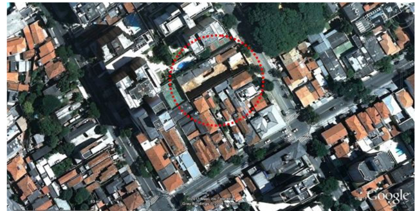
Figura 26 Localização do Edifício Fidalga 727. A imagem de Satélite mais recente é de 2011, porém o edifício não pode ser visualizado em maior nitidez. A imagem mostrada no trabalho é de 2008, época que estava começando a fundação do Edifício Fidalga; Fonte: http://triptyqueblog.blogspot.com/
