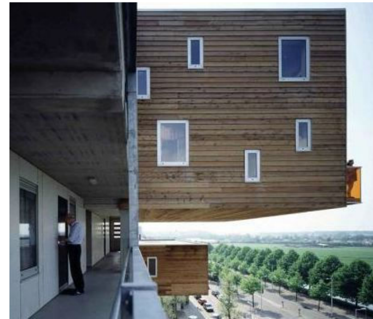
Figura 36 Corredor de acesso aos apartamentos do edifício Wozoco. O corredor se localiza na fachada norte (maior incidência de raios solares), para a iluminação dos apartamentos é utilizado janelas no corredor; Fonte: mvrdiv.nl/
