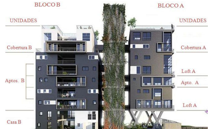
Figura 29 Organização das diferentes soluções de habitação no edifício Fidalga 727; Fonte: www.movimentoum.com.br
