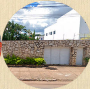
Figura 30: Fachada cega em residência na Av. Lourenço Dias. Fonte: Google Maps, 2020.
