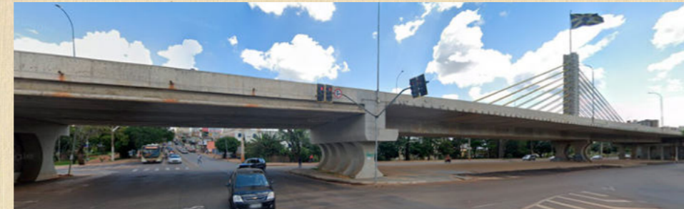
Figura 40: Trecho do viaduto próximo à área de intervenção na Av. Brasil. Fonte: Google Maps, 2020.
