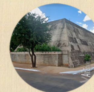
Figura 31: Obra da Câmara Municipal de Anápolis na Av. Brasil. Fonte: Google Maps, 2020.
