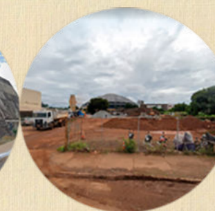
Figura 32: Terreno na Av. Brasil utilizado como canteiro de obras. Fonte: Google Maps, 2020.
