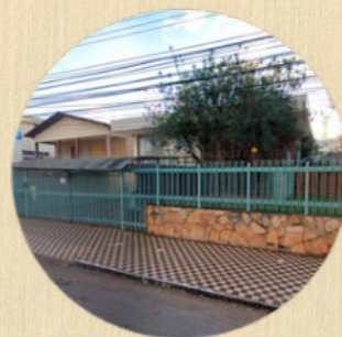
Figura 28: Utilização de gradios em fachada residencial na Av. Lourenço Dias. Fonte: Google Maps, 2020.
